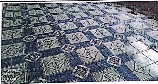
Foto 3: Terminacion de colocacion de piso ceramico en el interior del aula de la EORM Aldea Tzacpec.
