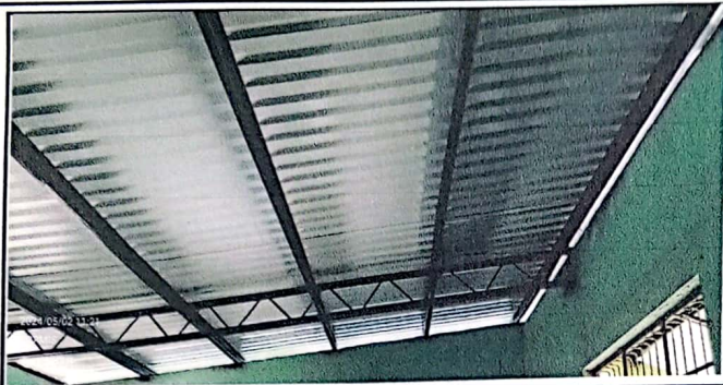
Foto 1: Terminacion de cambio de techo de la EORM Aldea Setzacpec
